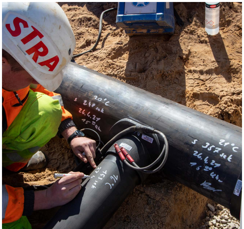
Der Sattel / Abgang d160 wurde erfolgreich geschweißt
