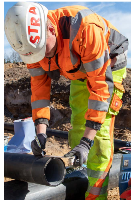
Die Schweißung wird vorbereitet
