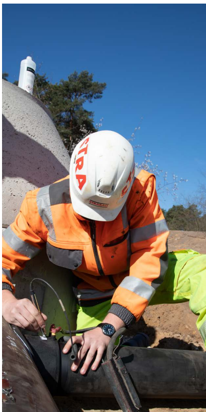
Einlesen des Schweißbarcodes eines FRIAFIT Sattels ASA TL
