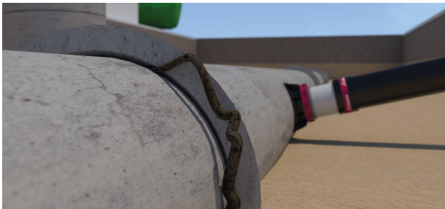
Kein schadhafter Wurzeleinwuchs mit Polyethylen
